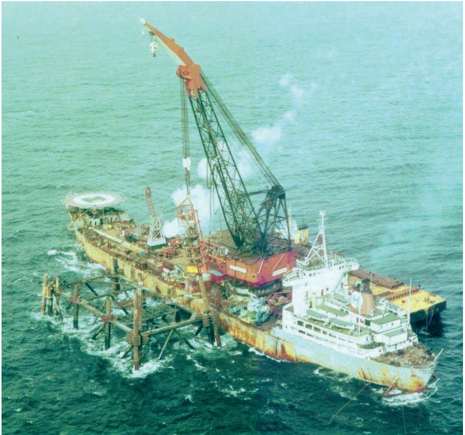
Challenger aan het werk. Hei werkzaamheden
